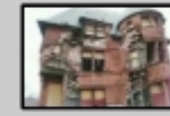
réhabilitations sur du bâti existant
